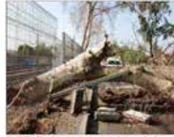
AV. PORTALES.— Este árbol cae sobre la reja de las vías férreas por efecto de la pérdida de estabilidad del ejemplar.
